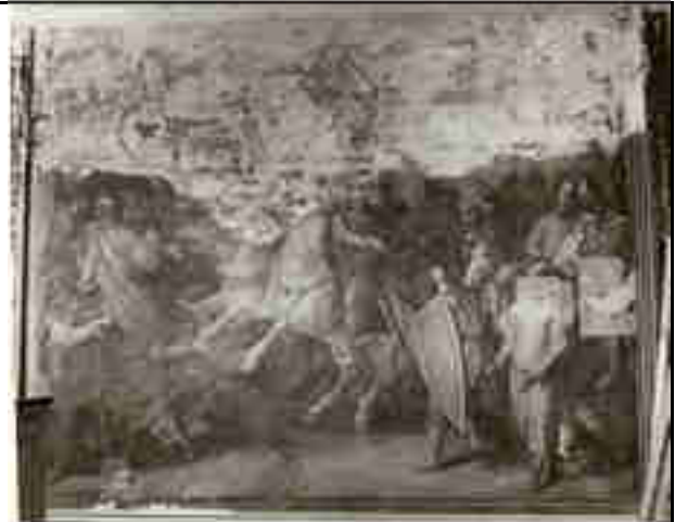
Abb.2: Aufnahme 1954, Kriegszerstörung Quelle: BSV Foto Albert Hunnemann
