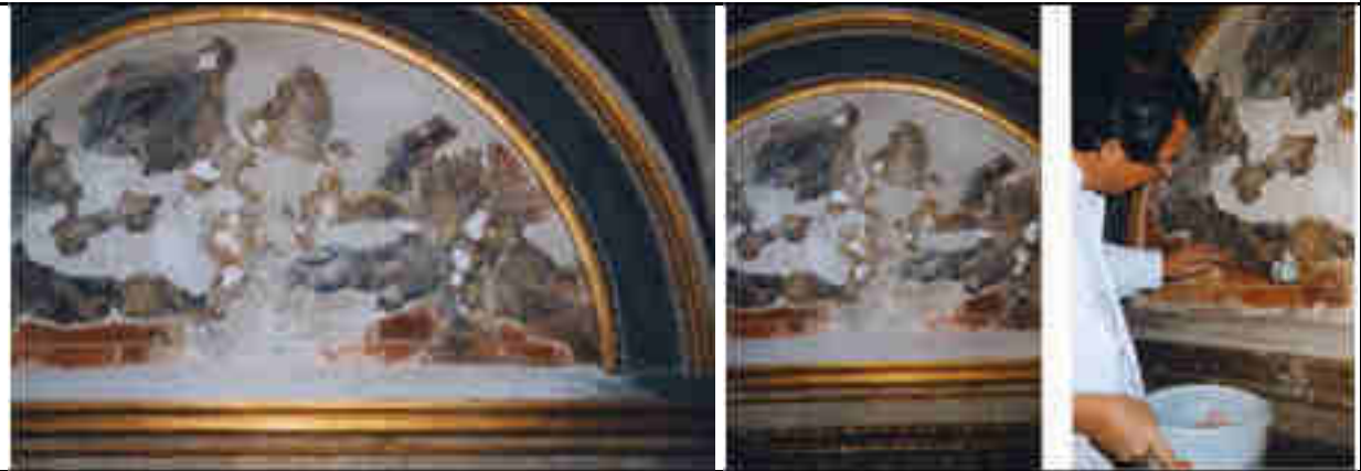
Saal des Verrats, Lünettengemälde. Die Aufnahmen zeigen verschiedene Stadien der Bearbeitung sowie Kunstmaler und Restaurator Antonio Angel beim Vormässen während der Putzergänzung.
