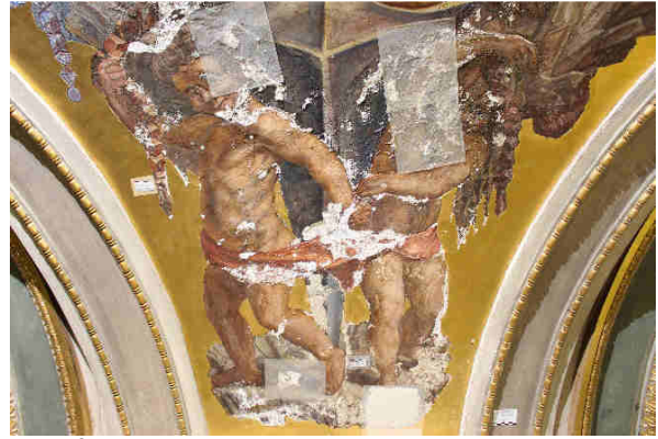
Salzschäden in Kassettendecke, Saal der Klage und im Gnomenfries, Saal des Verrats
