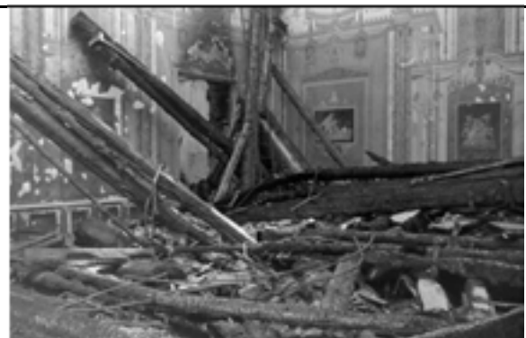
Appartement der Königin im Obergeschoss. Blick in den Salon der Königin nach 1945. Der über dem Saal des Verrats gelegene Raum ist mit dem Brandschutt der eingestürzten Dach- und Deckenkonstruktionen gefüllt.
