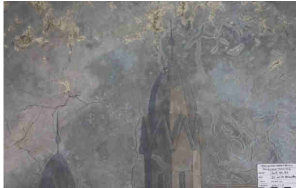
Dunkle Fleckenbildung und Verlust originaler Substanz infolge der Gipsbildung
