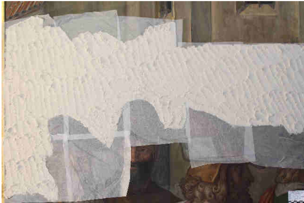
Mineralische Salzminderungskompressen, bereichsweise über Japanpapier aufgetragen
