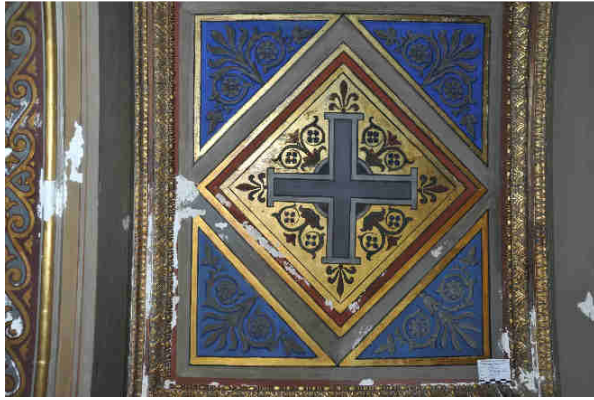
Salzschäden in Kassettendecke, Saal der Klage und im Gnomenfries, Saal des Verrats
