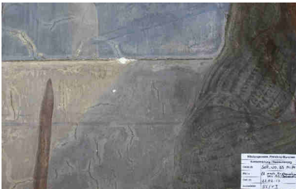
Dunkle Fleckenbildung und Verlust originaler Substanz infolge der Gipsbildung
